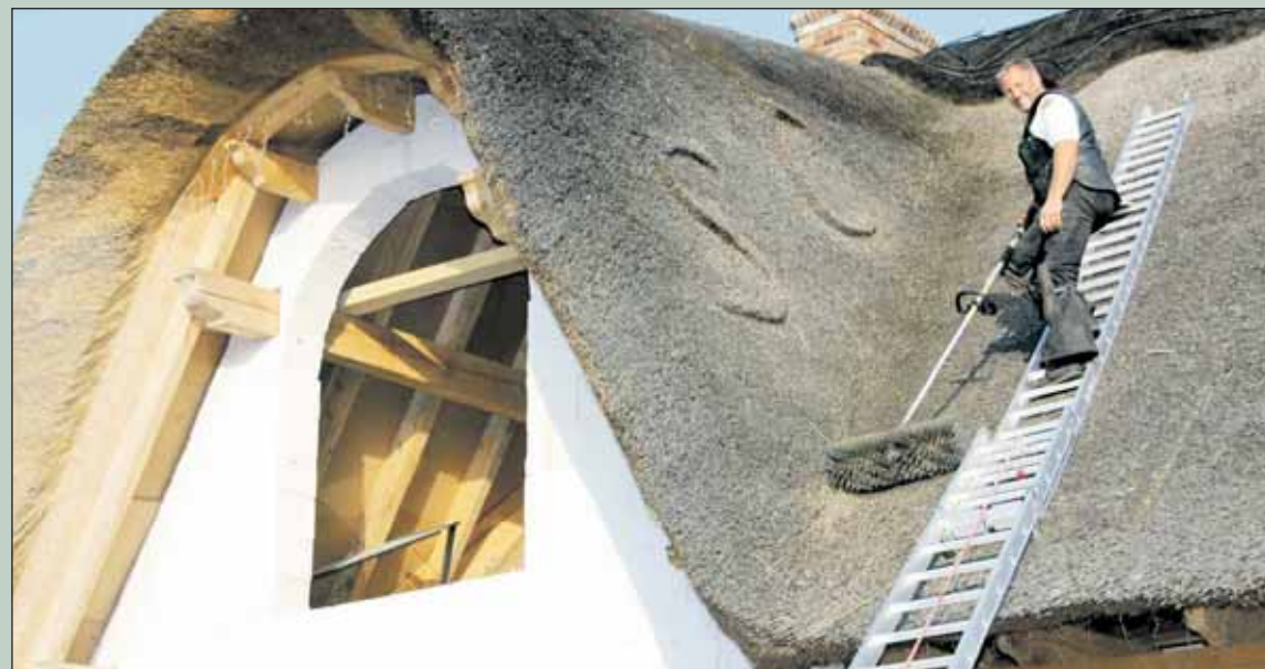
Der Reithdachexperte Christoph Behrens entfernt mit einem von ihm entwickelten Spezialbesen unerwünschte Dachbeläge im Handumdrehen.
